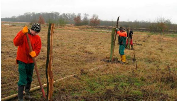
Abbildung 7.5: Zaunbau im Elbvorland
