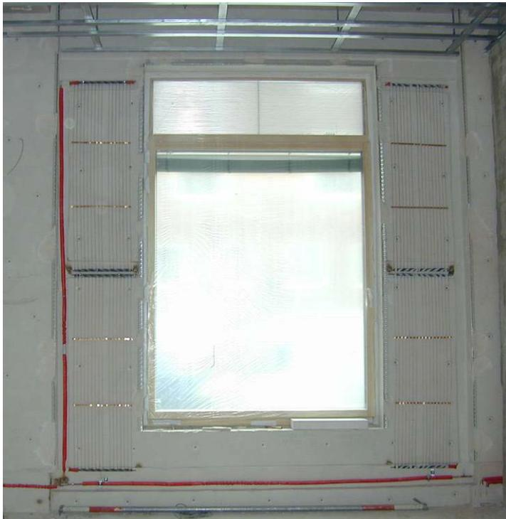
Abb. 32:Temperierungsleitungen vor dem Einputzen
