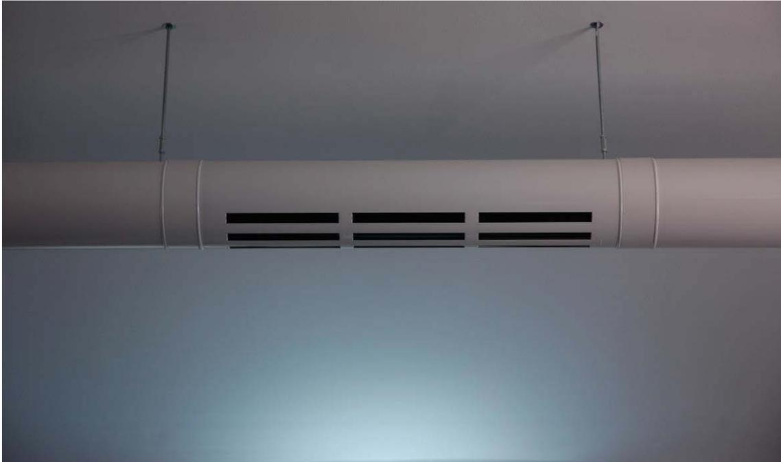
Abb.39: Zuluftauslass im Rundrohr
