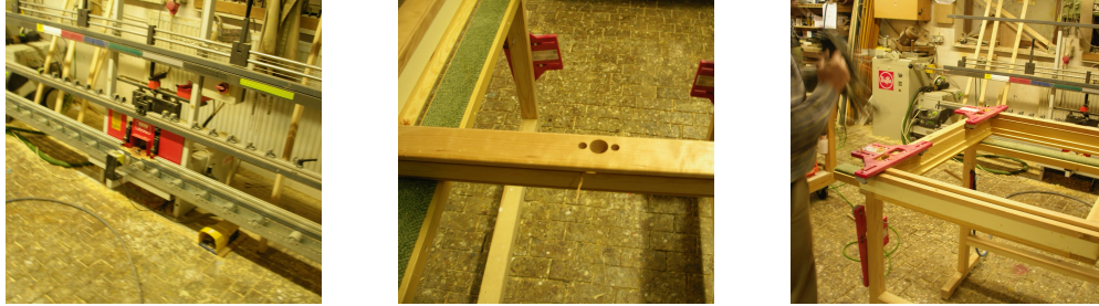
Abbildung 52: Die für die Beschläge notwendigen Löcher werden gebohrt oder gefräst.
