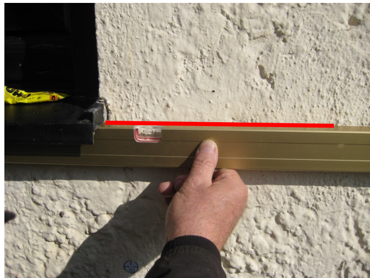
Abbildung 12: Kennzeichnung Unterkante Fenster
