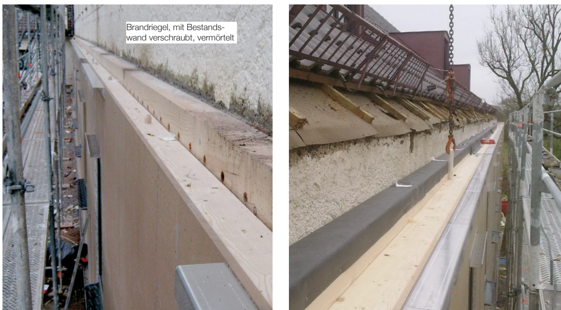
Abb. 46 Horizontaler Elementstoß und Dachabschluss (Foto links: BAUFRIITZ)
