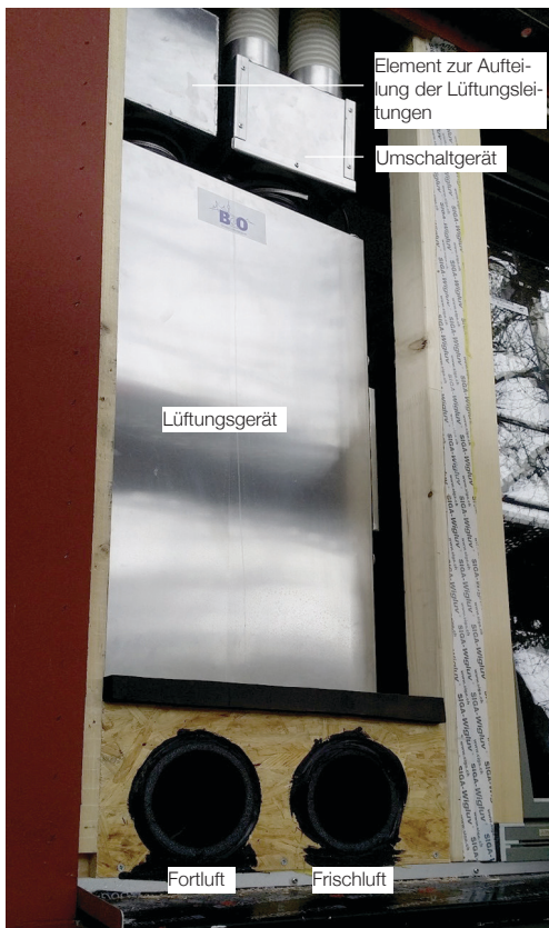
Abb. 48 Lüftungsbaustein vor Montage der Abdeckung (Foto: BAUFRTIZ)
