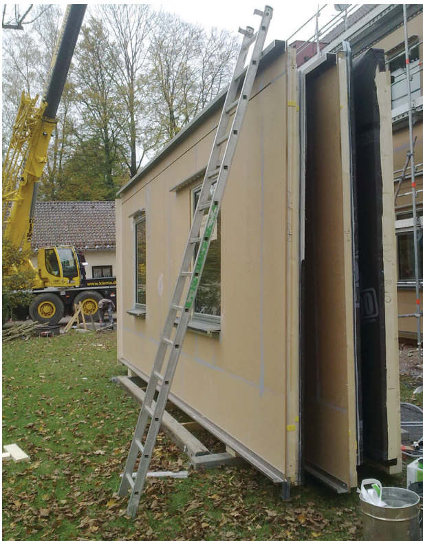
Abb. 45 Montage mit Autokran (Foto rechts: BAUFRTIZ)
