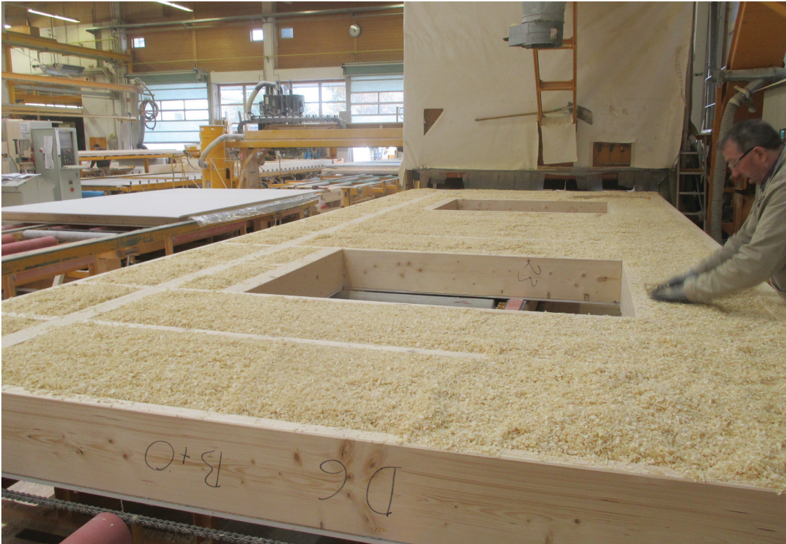
Abb. 41 Einbringen Hobelspandämmung (Foto: BAUFRTIZ)
