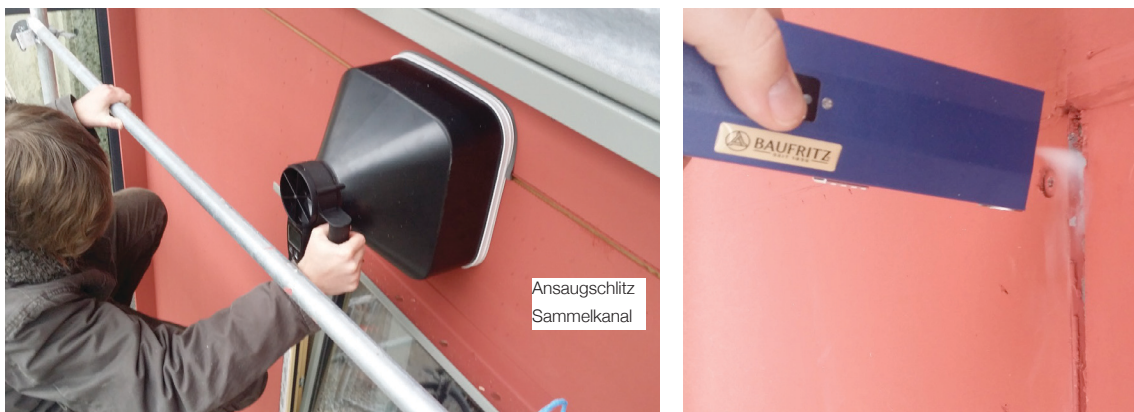
Abb. 50 Anpassung der Luftgeschwindigkeiten mittels Anemometer und Kontrolle der Dichtigkeit
