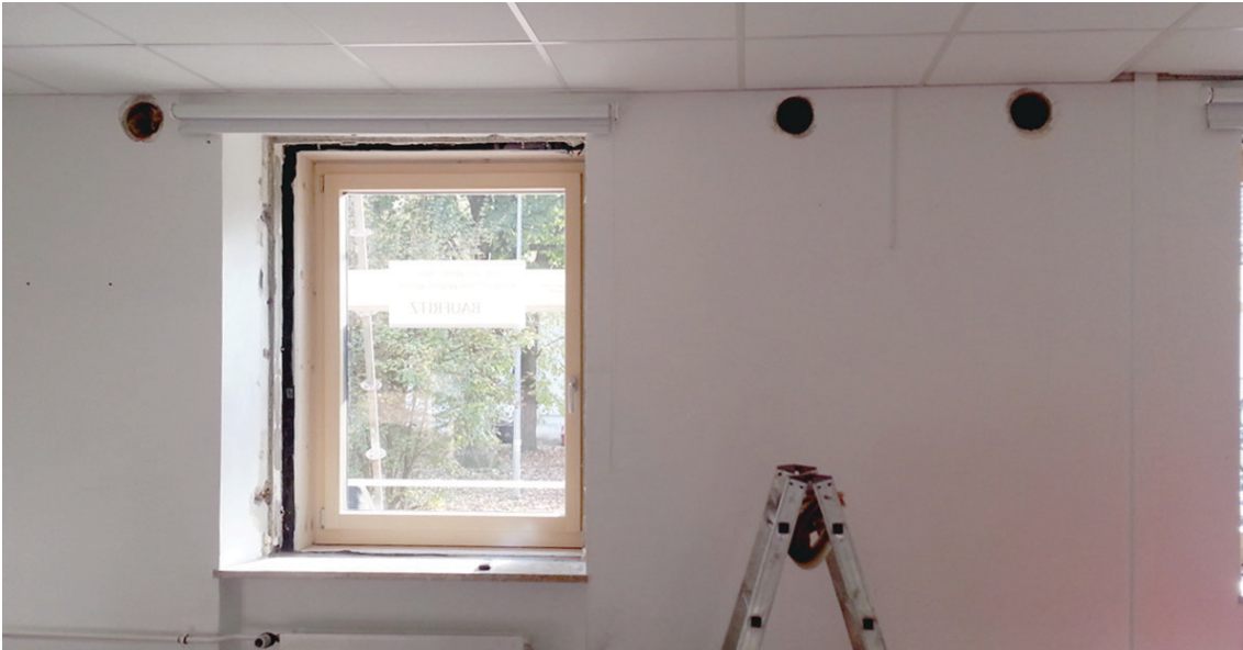
Abb. 47 Situation Zimmer während der Bauarbeiten (Foto: BAUFRTIZ)
