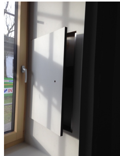
Bild 6: Klappenöffnung in der Laibung
