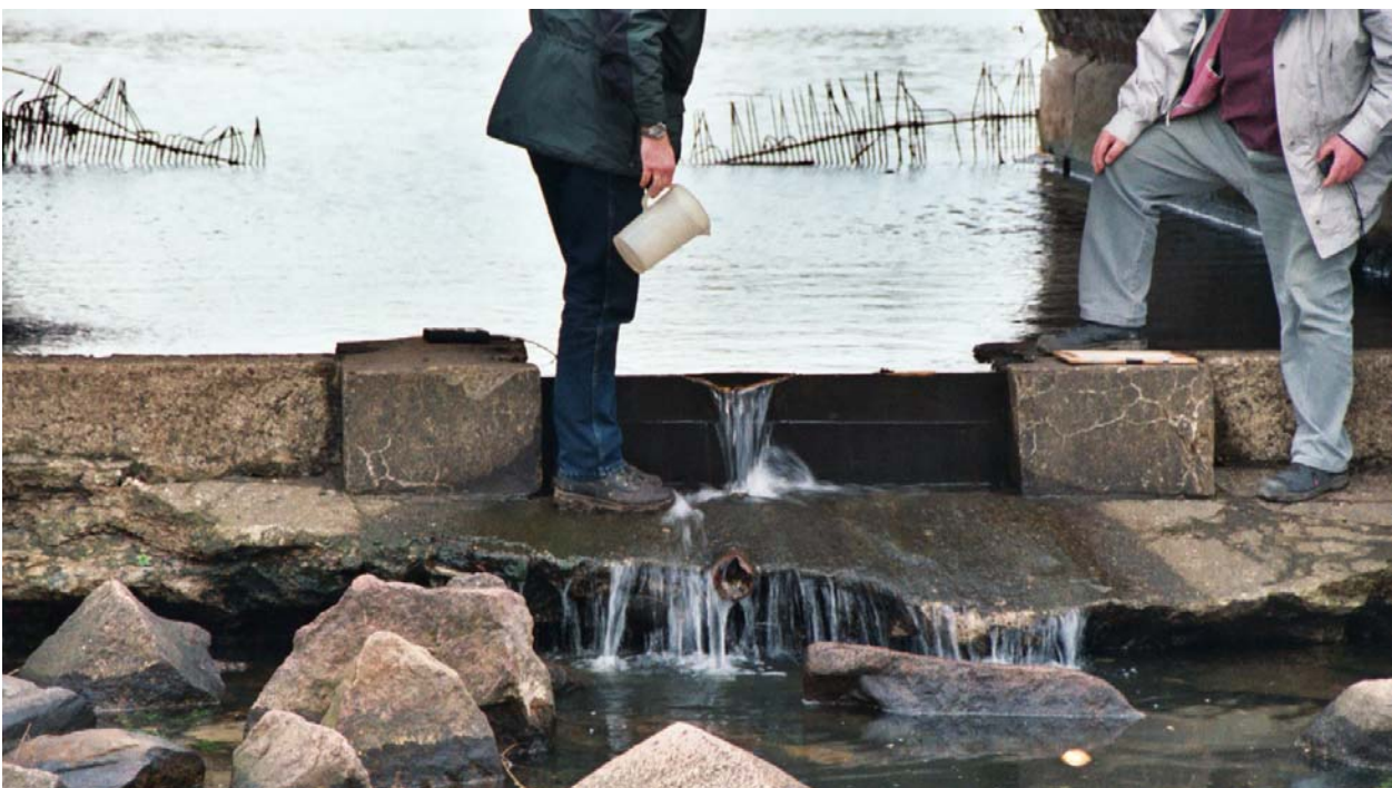
Abbildung 5-2: Biberkerbe in der Wehrtafel an der Friederikenbrücke
