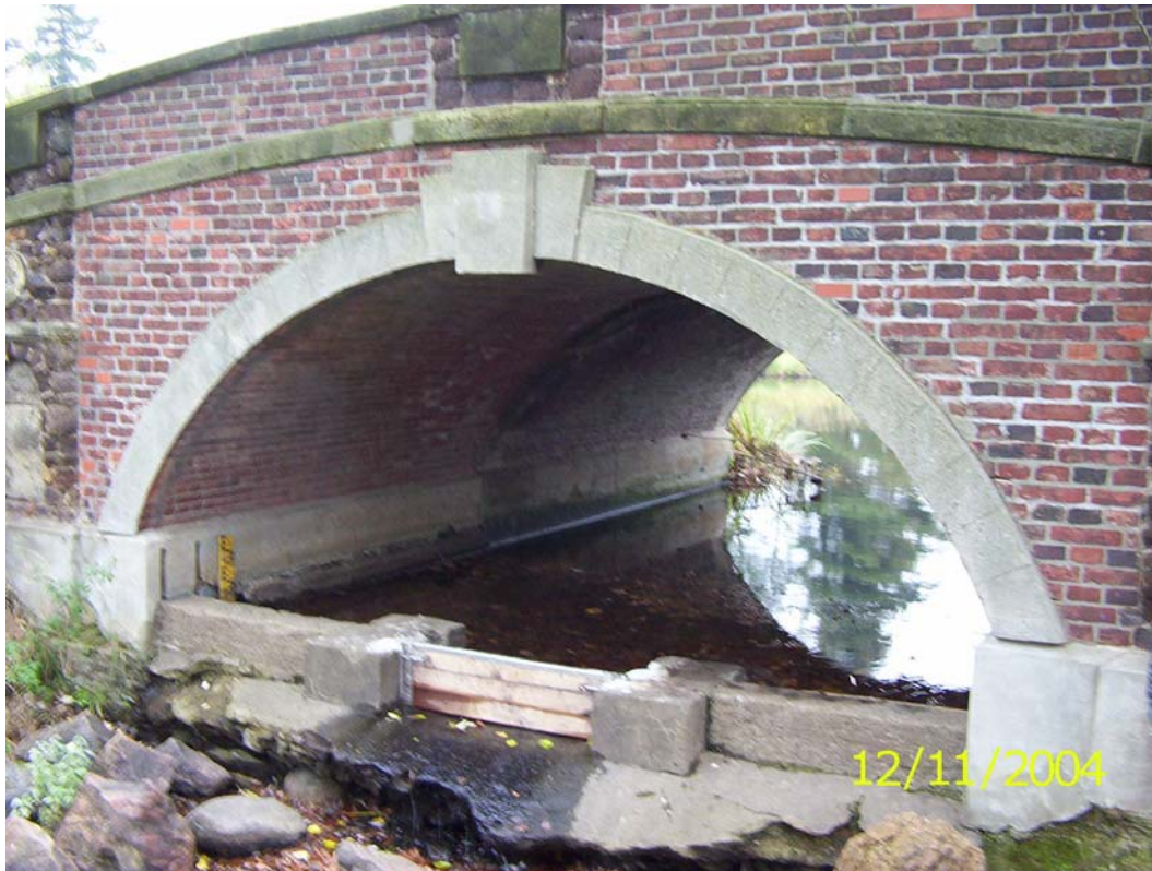
Abbildung 5-3: Friederikenbrücke nach Erneuerung der Wehrtafeln
