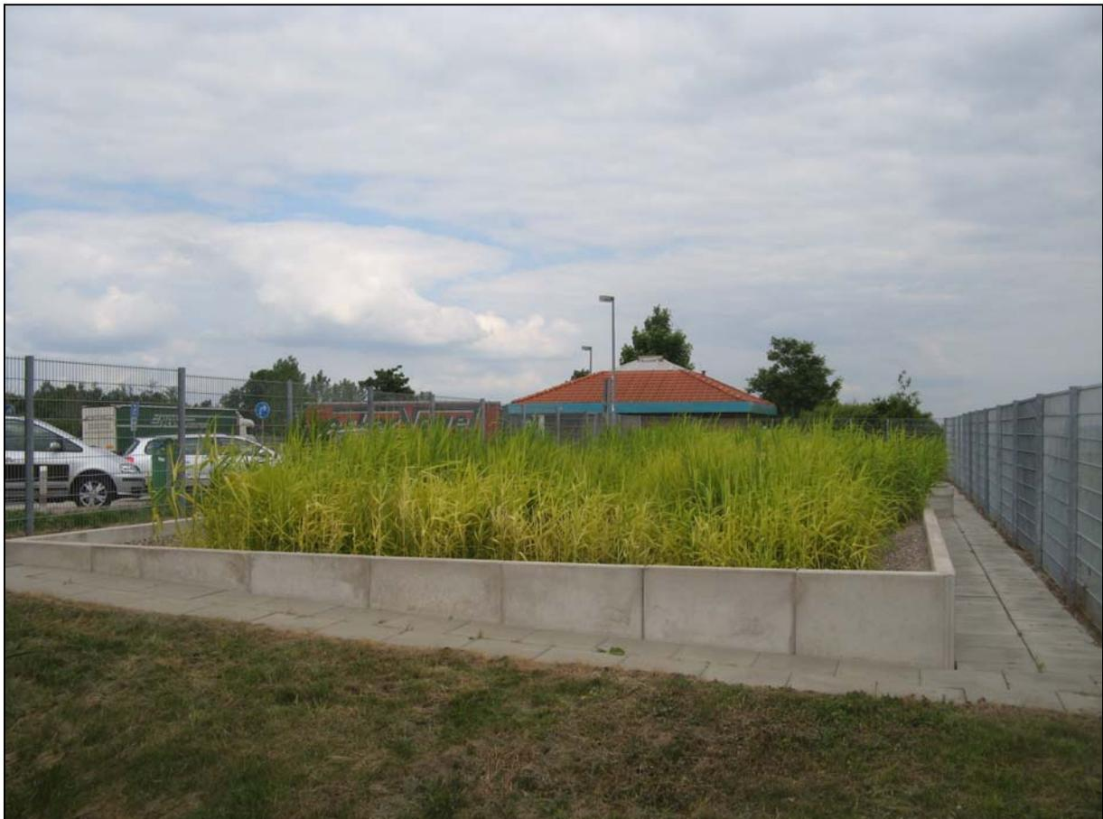
Abbildung 9: SUBTERRA-Pflanzenkläranlage (2x100 m<sup>2</sup>), PWC „Belvedere Süd“, BAB A4 (Foto: R. Emmerich, 22.6.2010)
