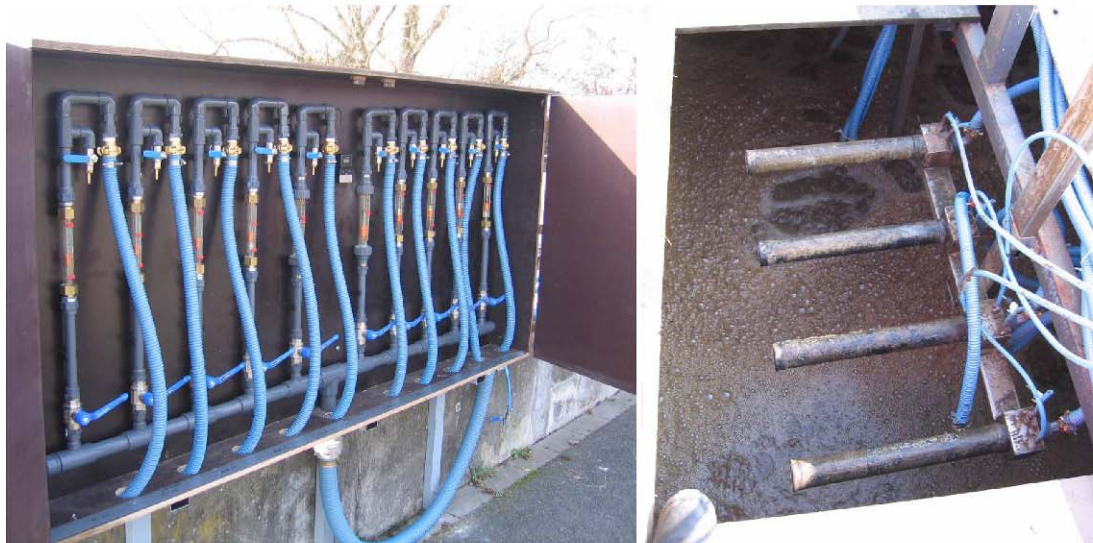
Abbildung 8 Messaufbau der Langzeitversuche
