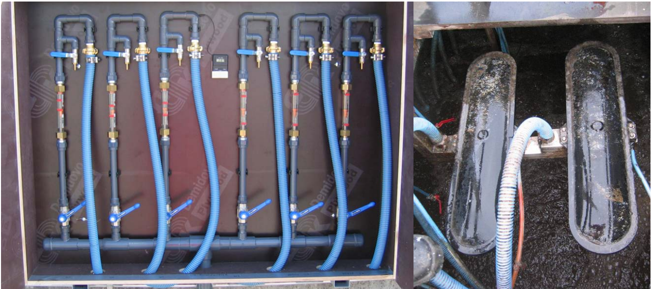
Abbildung 16: Versuchsstand B und dort eingebaute Plattenbelüfter
