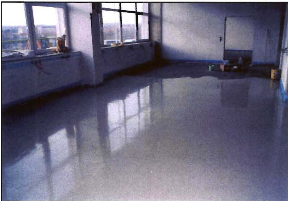
Bild 41: Beschichtung mit Epoxidharz 4
