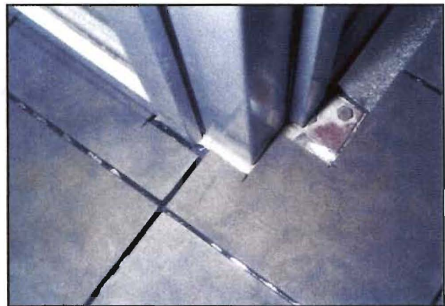
Bild 17: Anpassung nach Plattenzuschnitt
