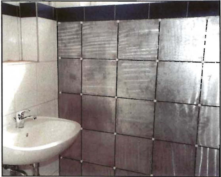
Bild 52: Probeverlegung, noch nicht verfugt
