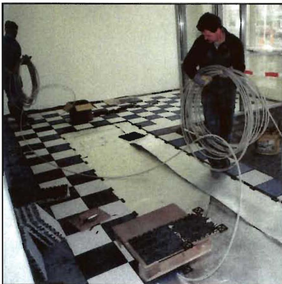
Bild 22: Vorstrecken der Rohre
