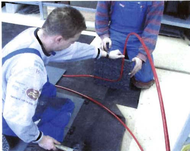
Bild 55: Testmontage Rohrumlenkung 2
