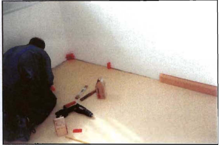
Bild 43: Sockelleisten
