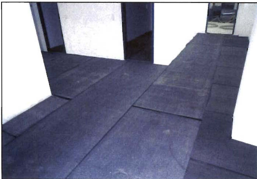
Bild 9: Verlegung der unbesandeten Bitumenpappe
