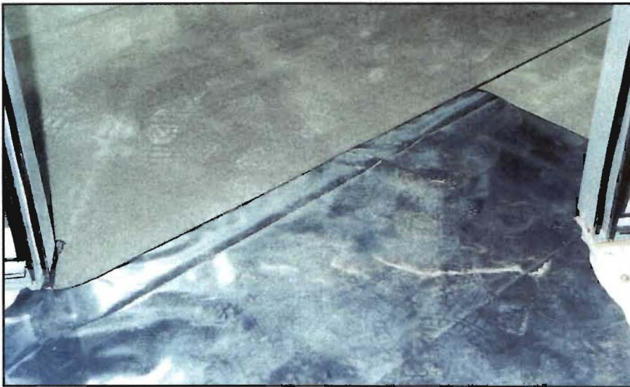
Bild 8: Verlegung der Trennfolie
