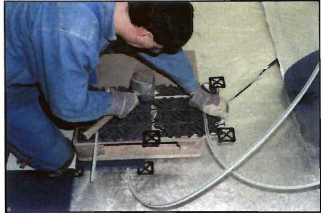
Bild 27: Vorbereitung Rohrumlenkung 4
