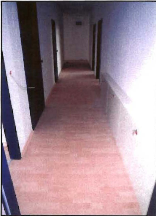
Bild 46: Fertige Laminatverlegung
