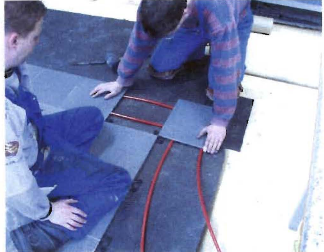
Bild 55: Testmontage Rohrumlenkung 3
