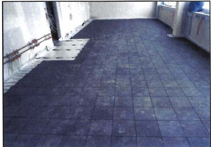
Bild 15: nahezu fertige Fläche in einem großen Raum
