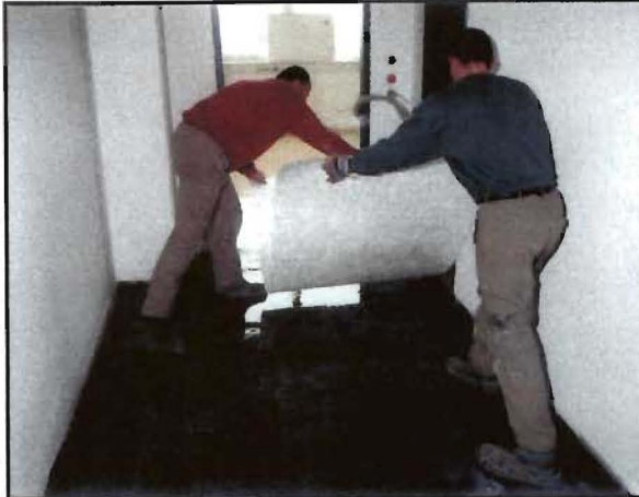
Bild 35: Armierung mit Glasvlies 1
