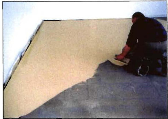
Bild 39: Beschichtung mit Epoxidharz 2
