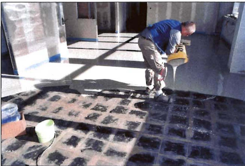
Bild 40: Beschichtung mit Epoxidharz 3
