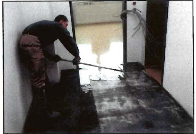
Bild 36: Armierung mit Glasvlies 2
