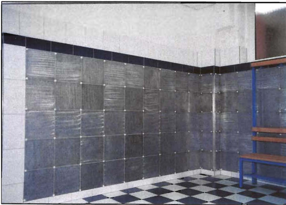
Bild 53: fertige Alu-Installation
