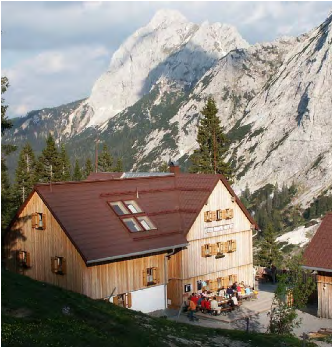
Bild 13 – OMH nach der Umbaumaßnahme - TD
