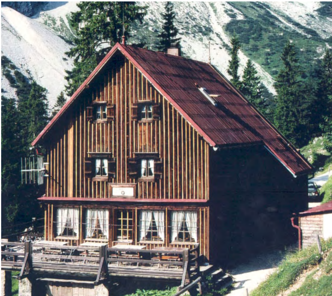
Bild 2 – OMH vor Umbaumaßnahme - unbekannt
