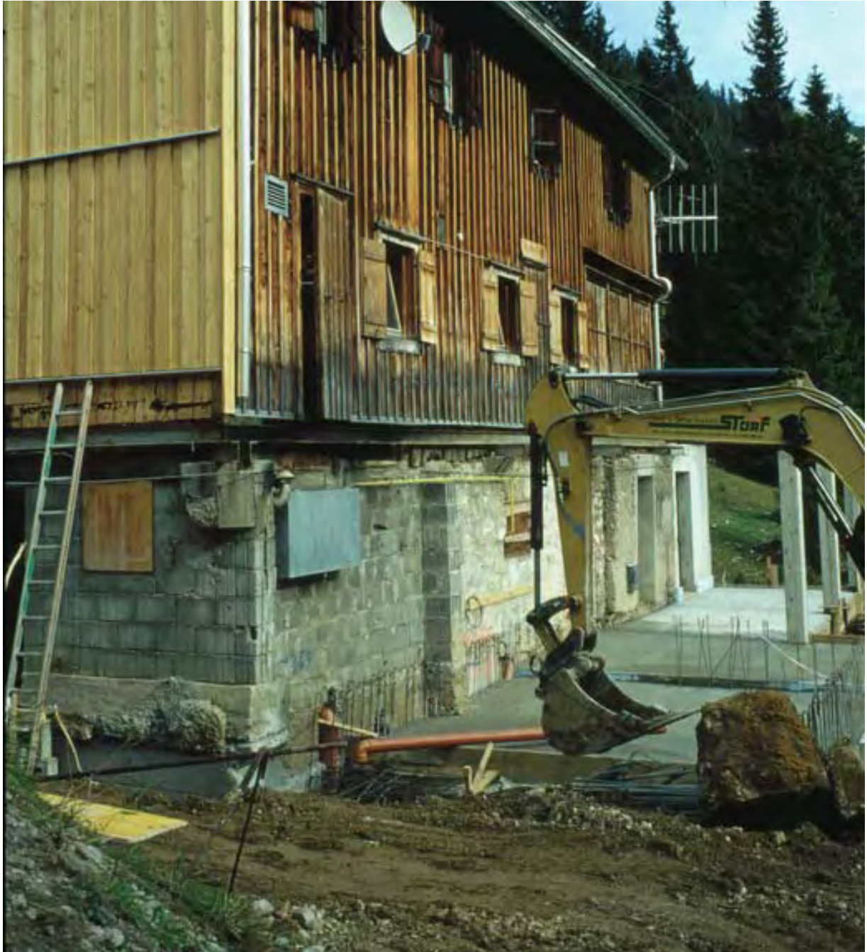
Bild 9 – OMH während der Umbaumaßnahme - unbekannt
