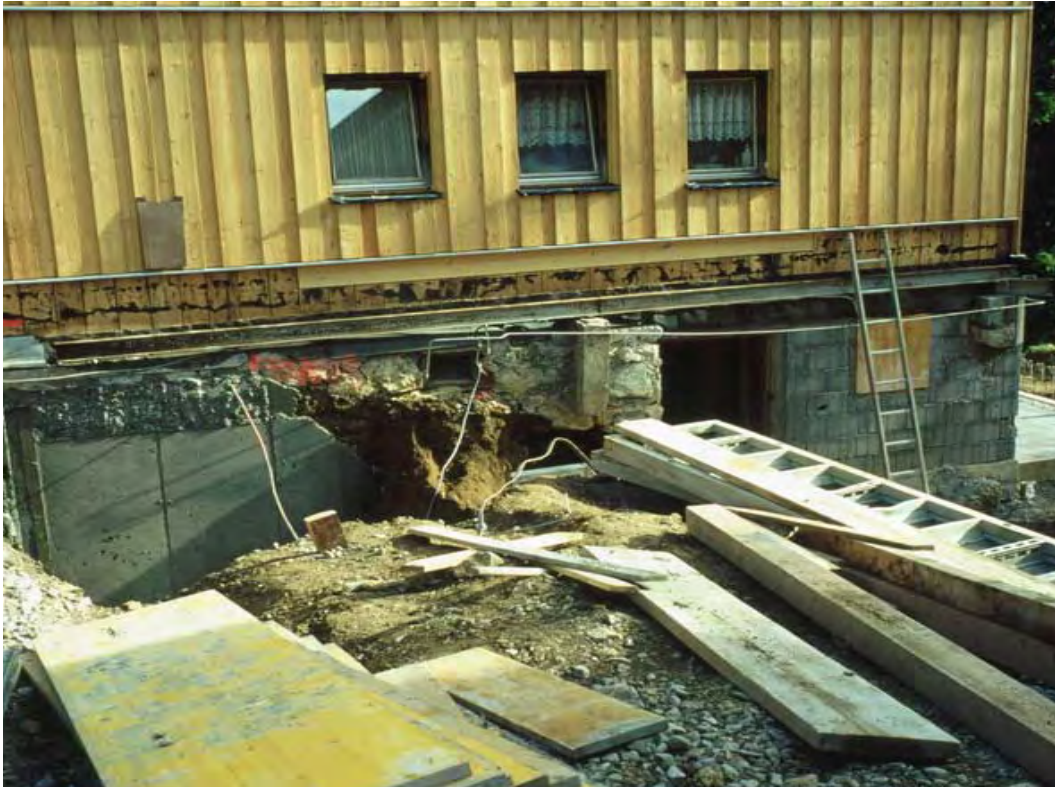
Bild 10 – OMH während der Umbaumaßnahme - unbekannt
