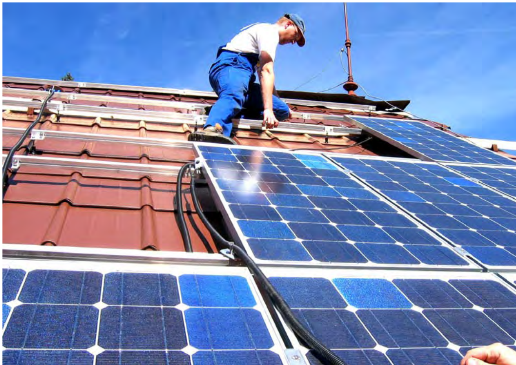
Bild 31 – OMH Montage PV-Module – Fa. Eisenbeiß
