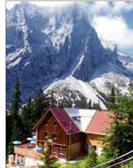
Die Otto-Mayr-Hütte des Alpenvereins wurde zum Modellprojekt für Umwelttechnik in den Bergen. Archivbild: Utzni
