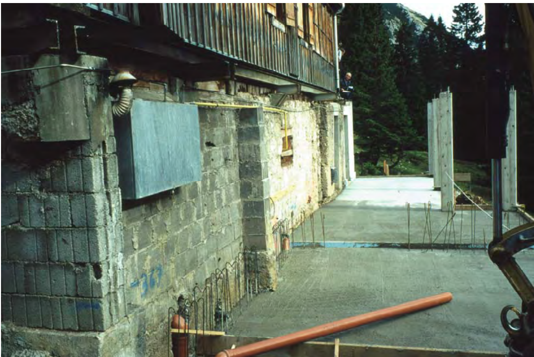
Bild 11 – OMH während der Umbaumaßnahme neuer Keller- unbekannt
