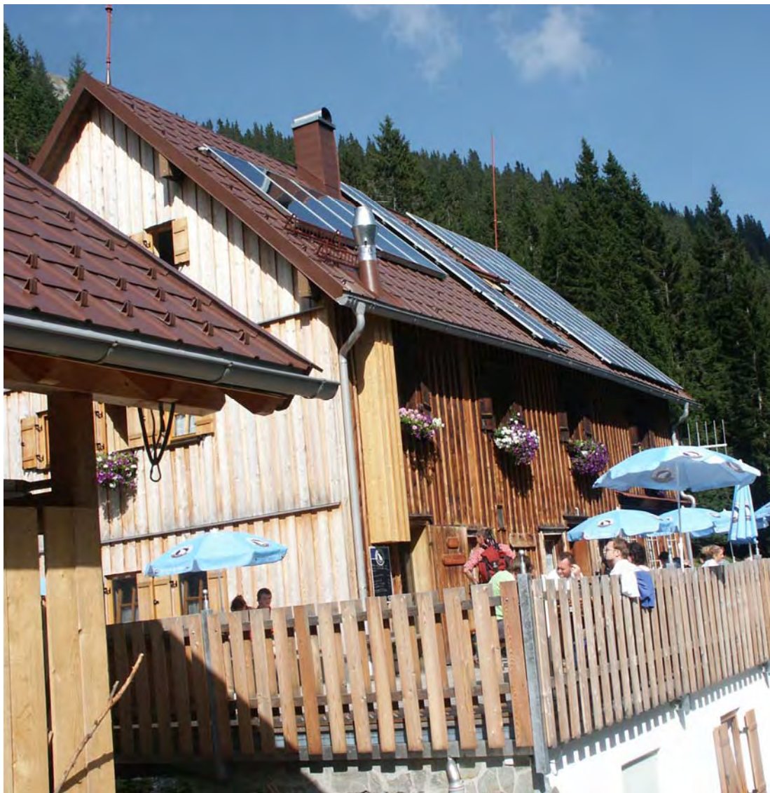
Bild 24 – OMH PV und Solarthermie auf dem Dach - TD
