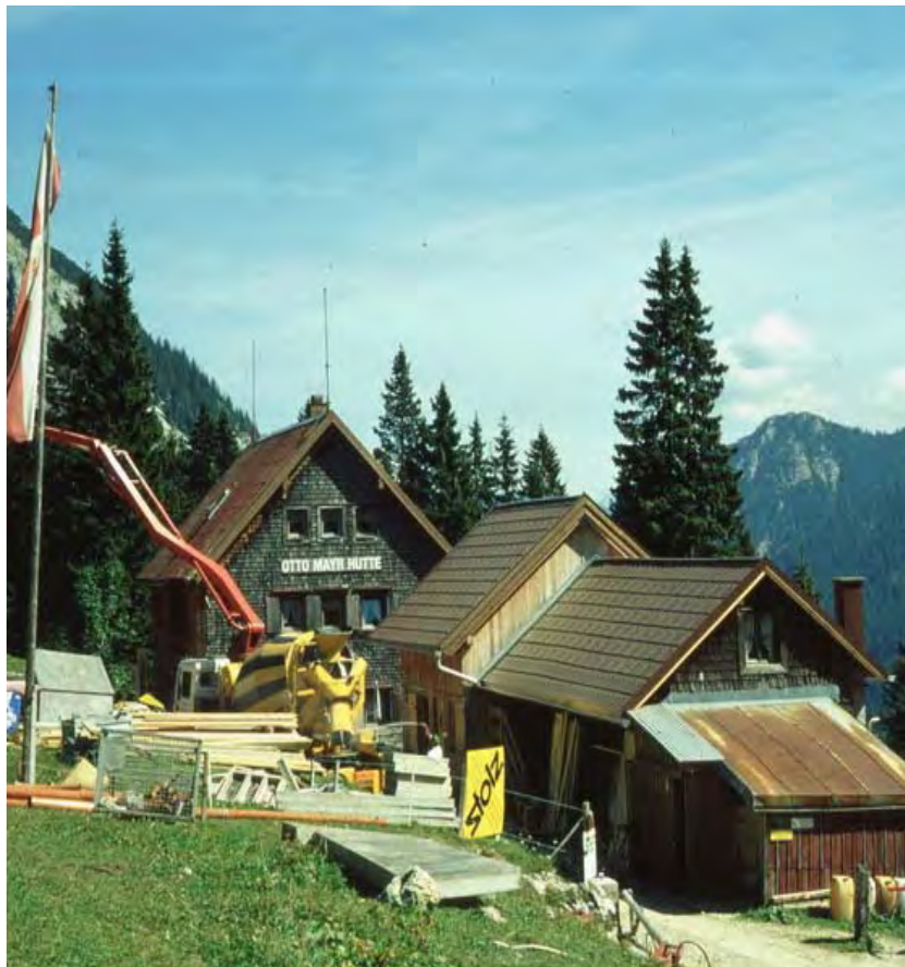
Bild 18 – OMH während der Umbaumaßnahme - unbekannt
