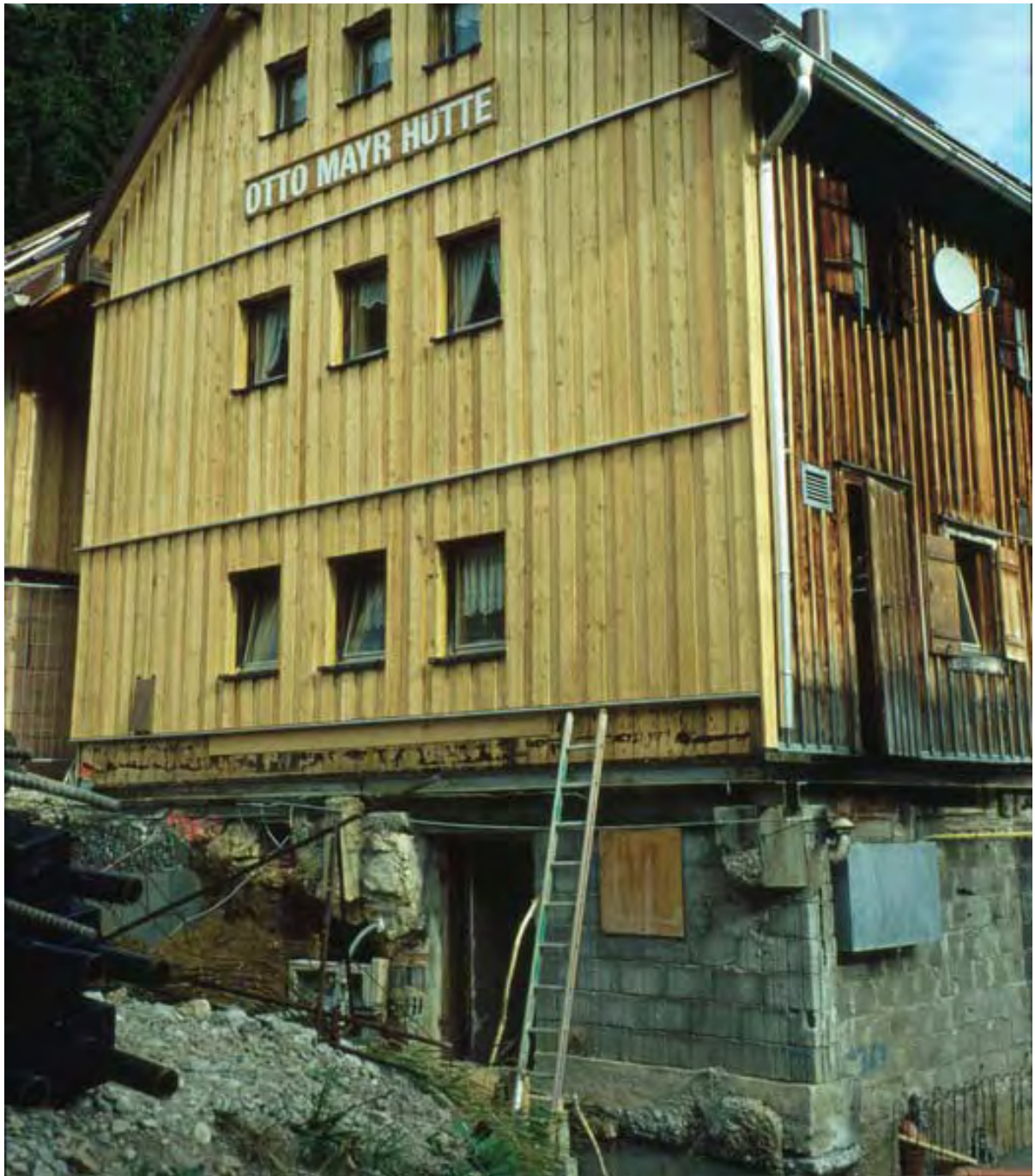
Bild 12 – OMH während der Umbaumaßnahme - unbekannt
