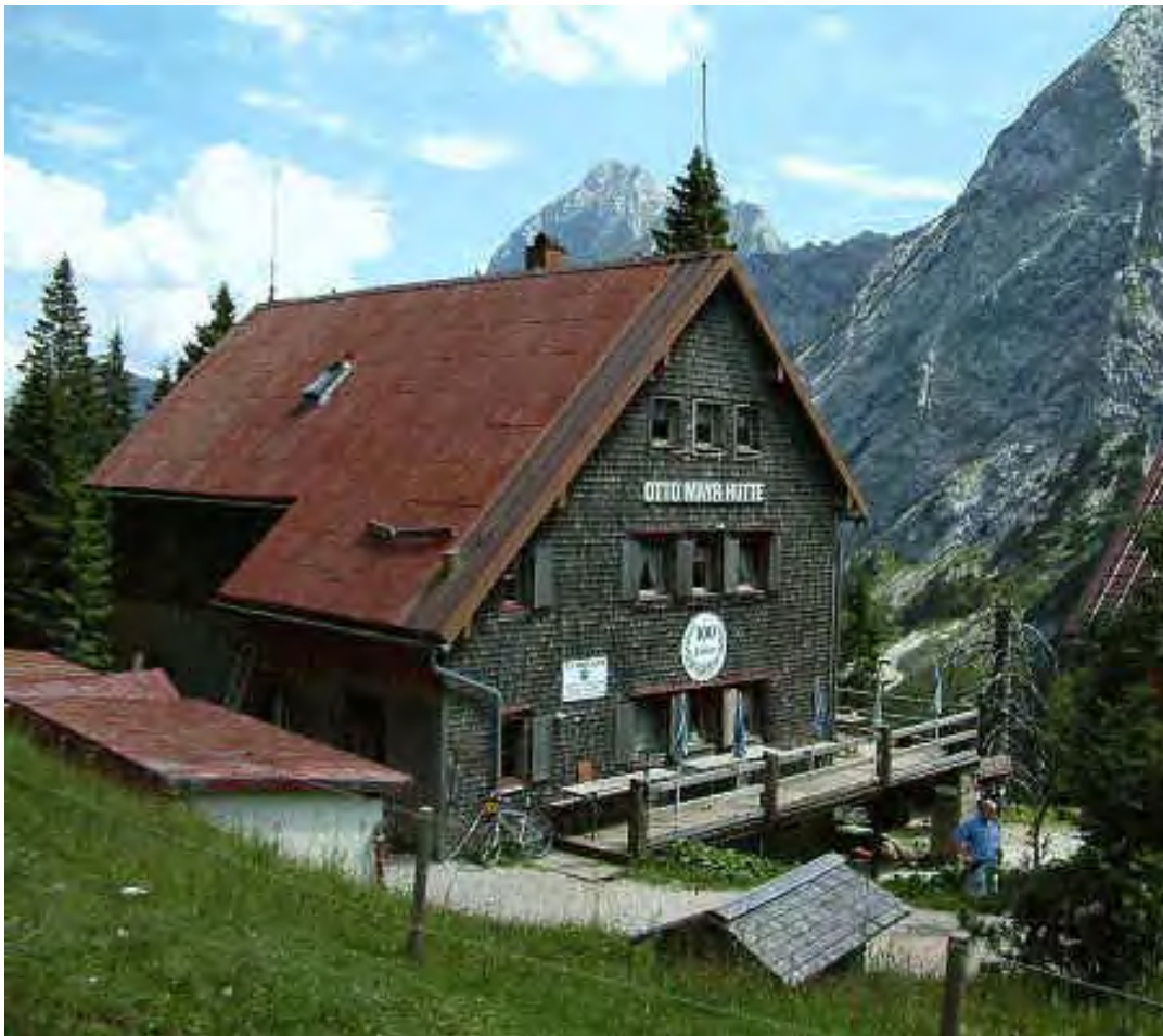
Bild 8 – OMH vor Umbaumaßnahme - unbekannt
