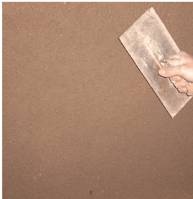
Abb. 6 Antragen und Abgleichen des Putzes
