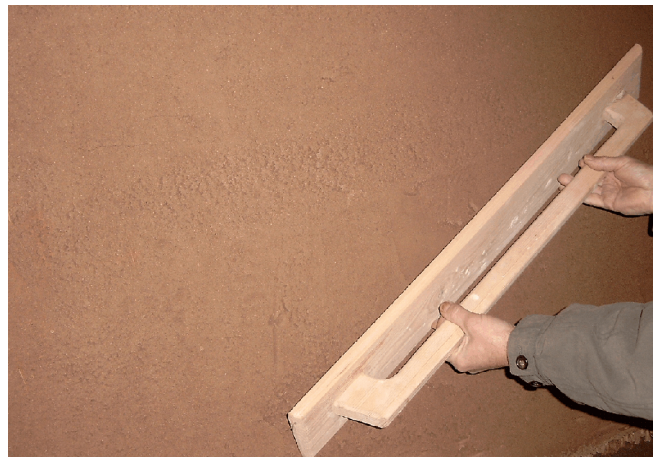
Abb. 4 Abgleichen des Putzes
