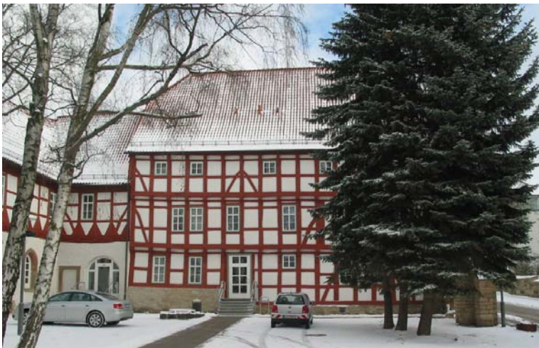
Abbildung 64 Foto der Südseite
