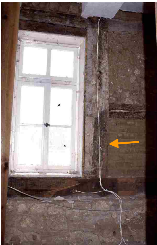
Abbildung 46 Messstellen vor dem Verputzen (Beispielhaft Raum 0.14)
