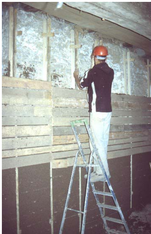
Abbildung 9 Lattung und Schalung, Wellpappe zur Trennung von Holz und Lehmshale
