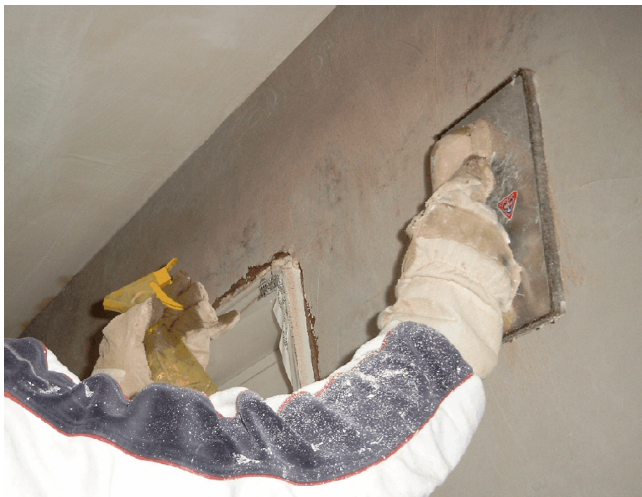
Abb. 8 Die aufgespachtelte Kalkschlämme wird mit dem Filz in den Lehmputz eingerieben.
