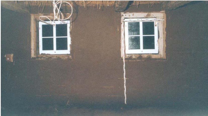
Abbildung 34 Ansicht Außenwand im Raum 2.6
