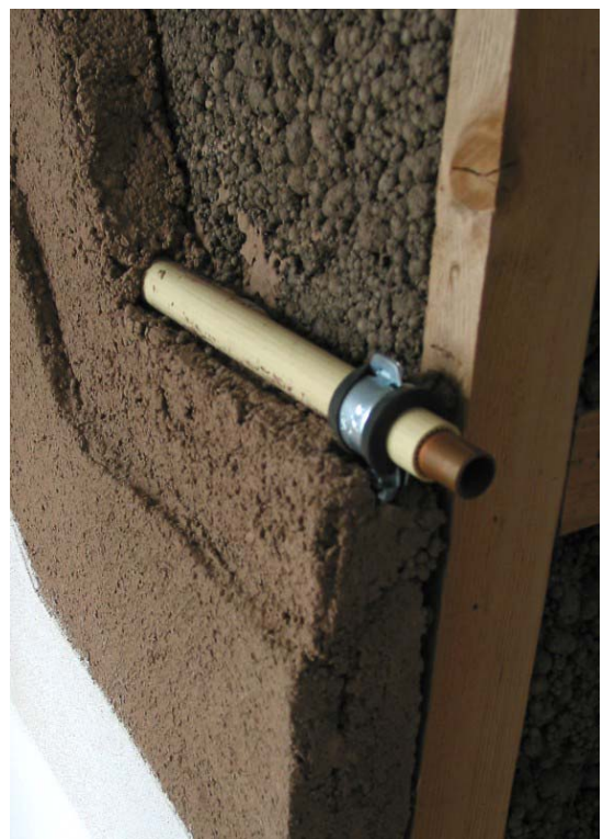
Abbildung 14 Heizrohre im Sockel- und Brüstungsbereich sowie Fensterumfahrung
