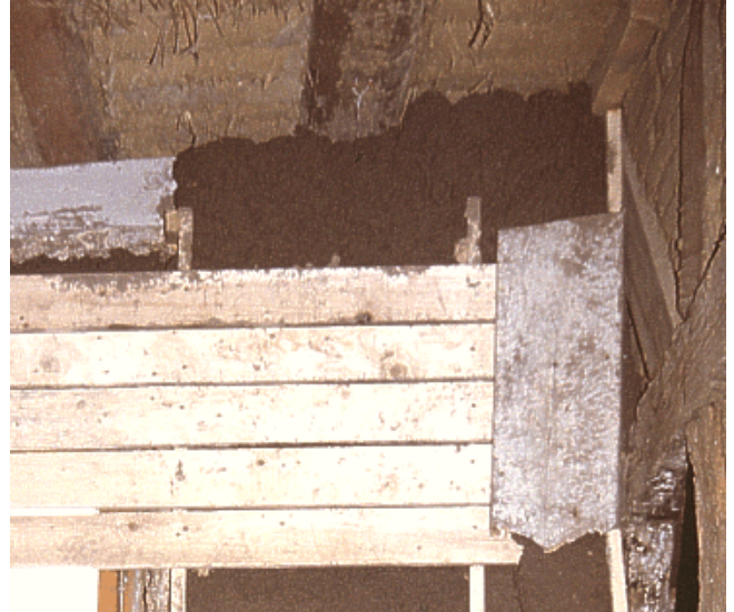
Abb. 4 Im oberen Anschluss wird das Material mit der Kelle eingefüllt.
