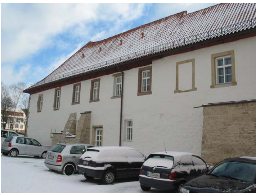
Abbildung 68 Foto der Westfassade
