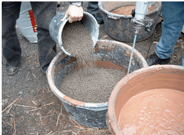
Abb. 3 Die Leichtzuschläge werden mit der Lehmschlämme verrührt.
