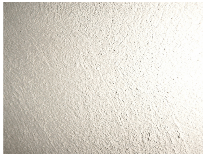
Abb. 10 abgetrocknete weiße Kalkoberfläche
