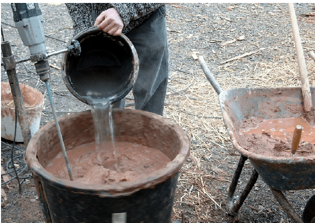
Abb. 1 Für die richtige Konsistenz wird der gemaukte Lehm mit Wasser verrührt.
