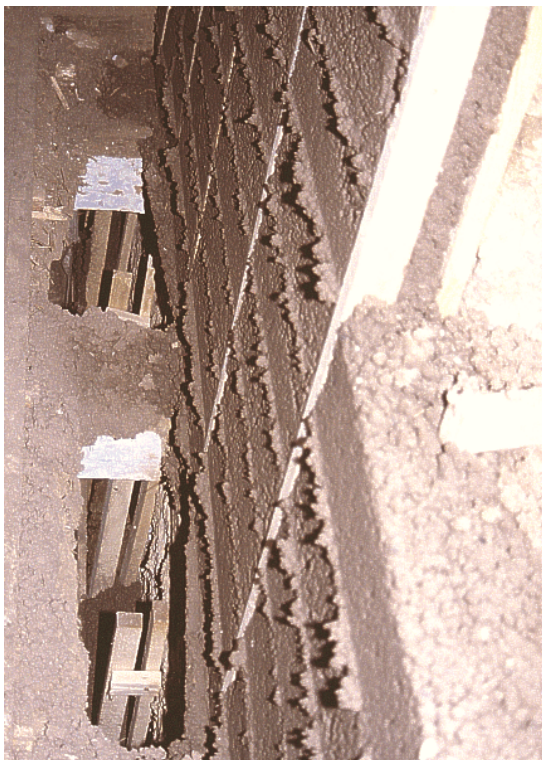
Abb. 3 Leichtlehmschale wird durch die Decke geführt
