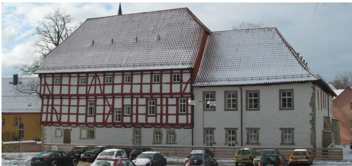
Abbildung 58 Foto der Nordfassade
