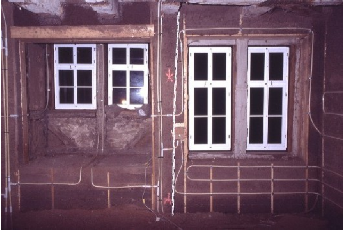
Abb. 3 Beispiel für Rohrverlegung
