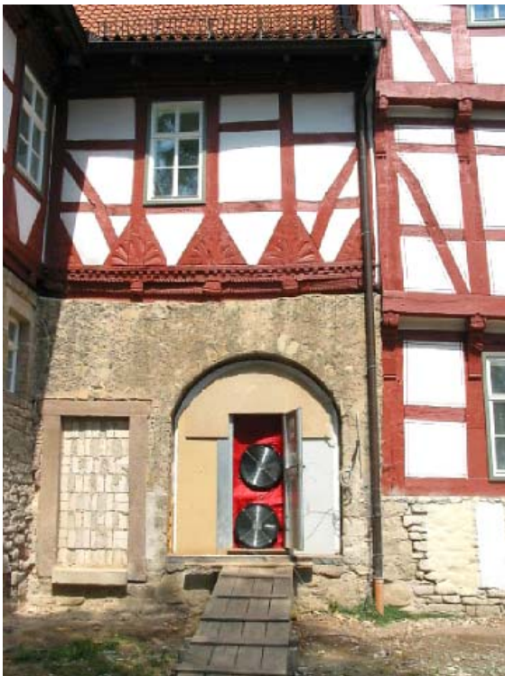
Abbildung 73 BlowerDoor in der Hauseingangstür
