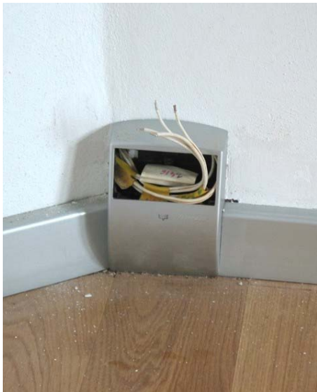
Abbildung 44 Zusammenführung von Messleitungen in Aufputz-Installationsdose
