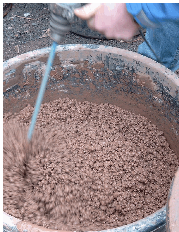
Abb 7 Anmischen des Mineralleichtlehms
