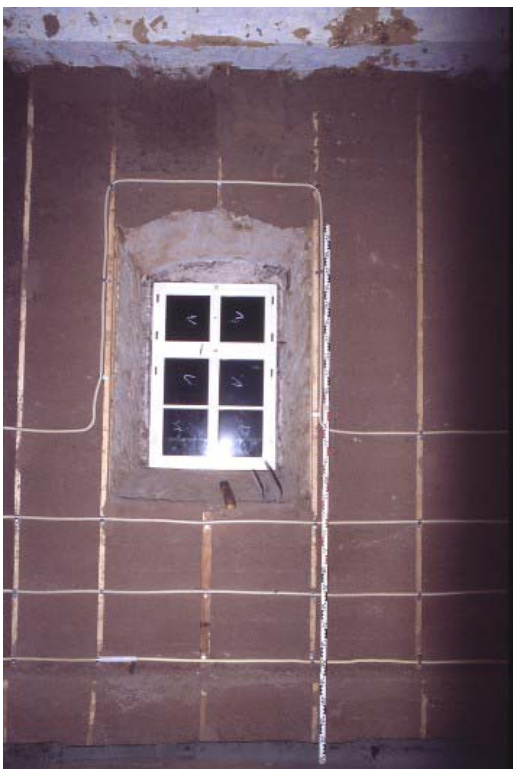
Abbildung 14 Heizrohre im Sockel- und Brüstungsbereich sowie Fensterumfahrung
