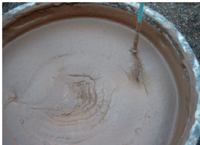
Abb.3 Mit Wasser wird der Lehm verrührt.
