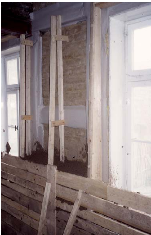
Abbildung 9 Lattung und Schalung, Wellpappe zur Trennung von Holz und Lehmshale
