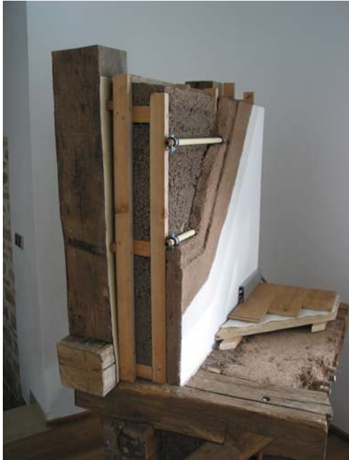
Abbildung 21 Modell des Wandaufbaus
