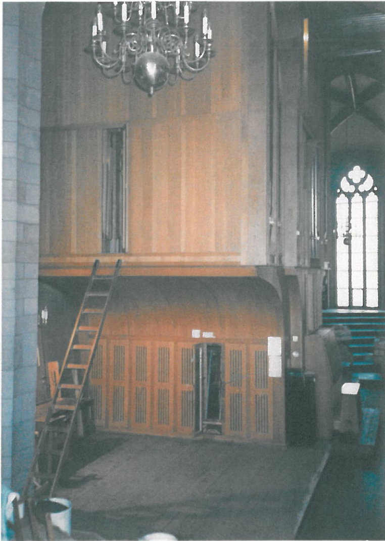
619.1 Lüftungsschlitze an den seitlichen Füllungen und Türen des Orgeluntergehäuses
