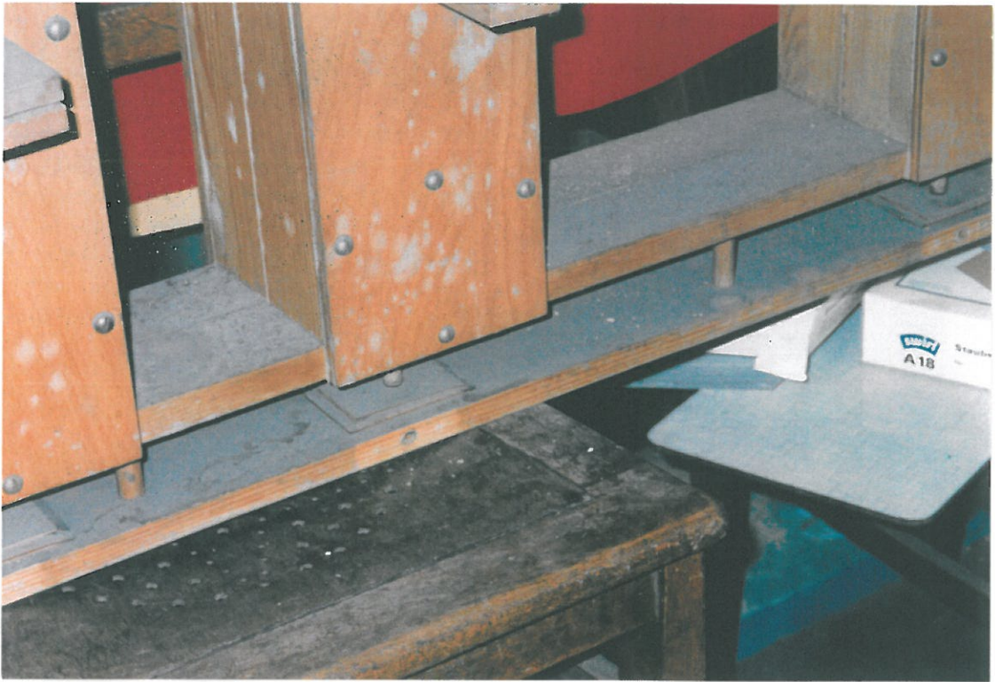
409.11 Registerzugapparate: Staub auf Membranleiste und Ledermembranen Pilzbefall an den Holzgehäusen
