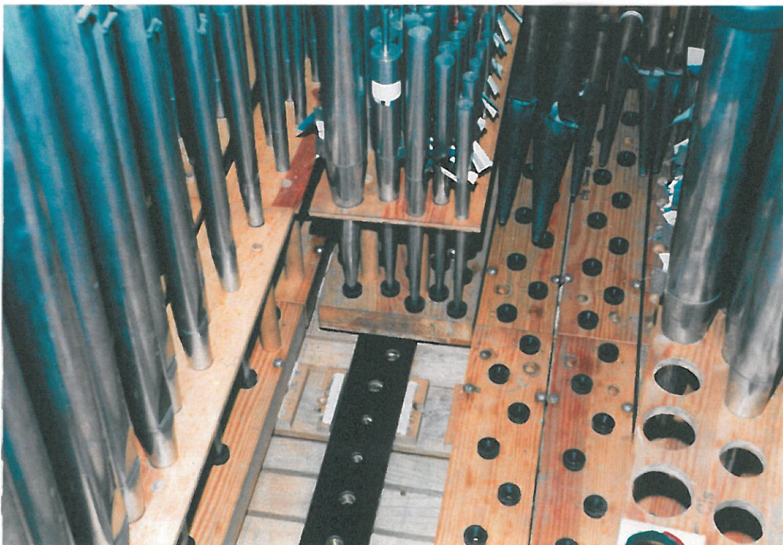
609.4 Wiedereinbau der gereinigten und instandgesetzten Pfeifen, Pfeifenstöcke und Rasterbretter. Im Vordergrund eine neu eingebaute Schleife.
