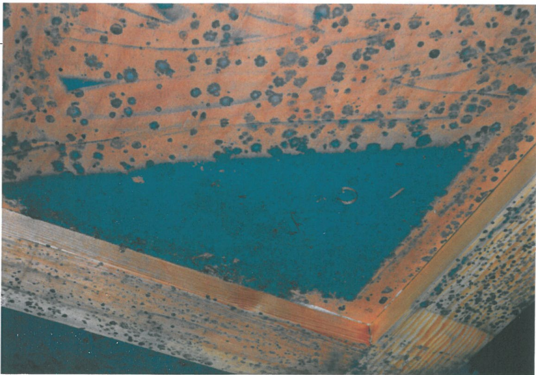
409.10 Pilzflecken an einer Balgplatte Im Vordergrund ist das blaue Dichtungspapier abgelöst.
