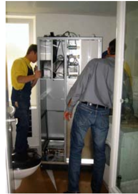
Installation des Lüftungs-Kompaktgerätes
