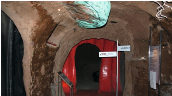
Die Inszenierung einer unterirdischen Höhlenlandschaft: Im Hintergrund erkennt man eine Röhre aus GFK. Die Formen im Vordergrund basieren auf Metallkonstruktionen, Drahtgeflecht und Gips.
